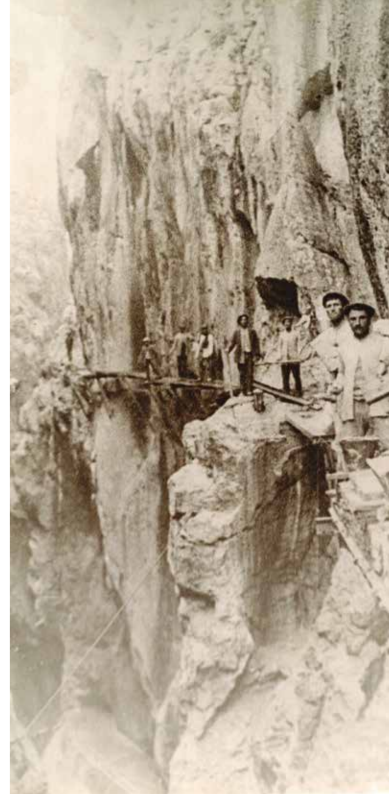
Operarios durante la construcción de las pasarelas de cemento e hierro. Las que terminó recorriendo el Rey.
